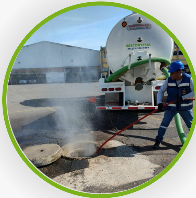
Sondeo y limpieza de drenajes
