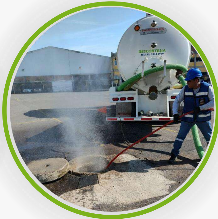
Sondeo y limpieza de drenajes
